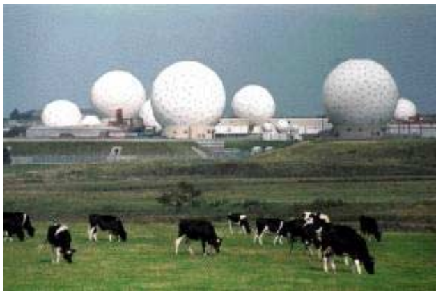
Obr.: Centrum F83, rozsáhlé podzemní pracoviště systému Echelon
